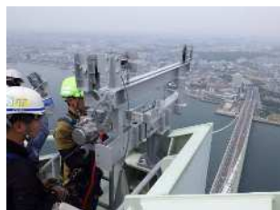
吊元設置作業
