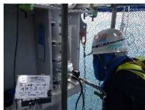
防錆材注入状況
