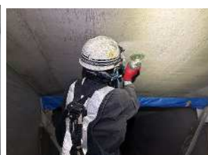
下地処理作業
