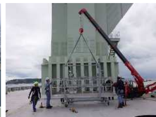
作業車組立作業
