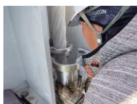
外装被覆処理状況
