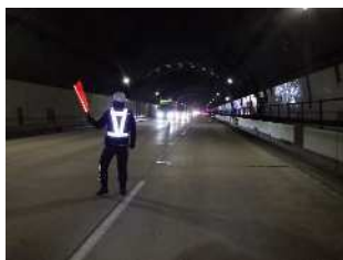
走行車線規制 （夜間）
