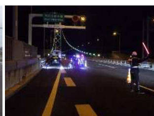
走行車線規制 （夜間）
