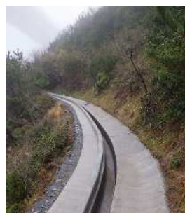
のり面排水改良工
