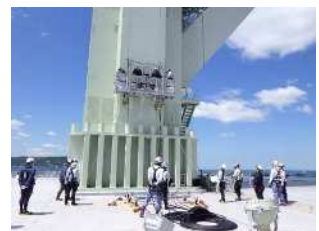
作業車設置作業
