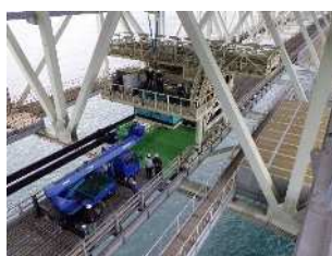
発電機搬出作業
