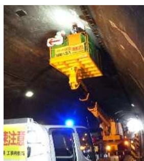
トンネル補修
