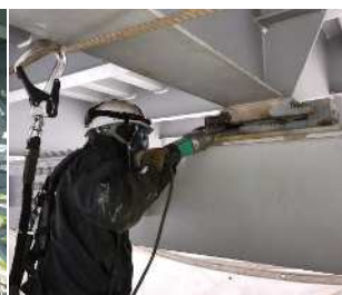
補修塗装状況
