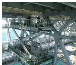
点検補修用桁内面作業車
