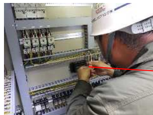
変換ユニット接続作業
