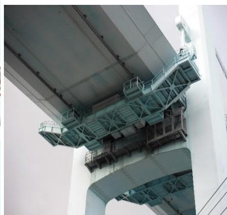
点検補修用桁外面作業車
