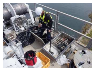
ケーブル更新状況
