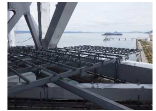
ステージ設置完了
