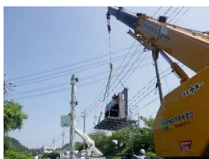
道路情報板撤去作業
