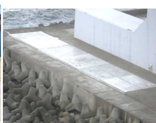
コンクリート 打設完了 (7P)
