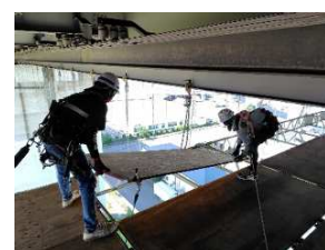
足場仮設状況
