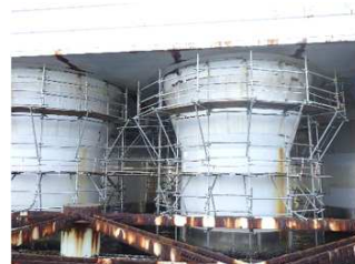
柱足場設置完了 (4P)
