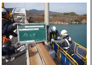
道路照明柱設置作業
