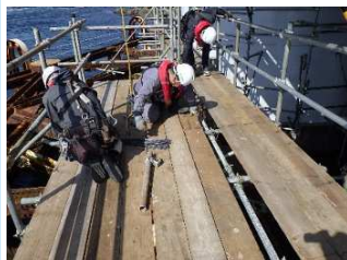
通路設置状況
