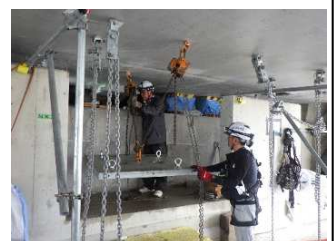
新規支承取付状況
