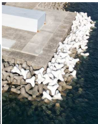
消波ブロック 設置完了 (5P)
