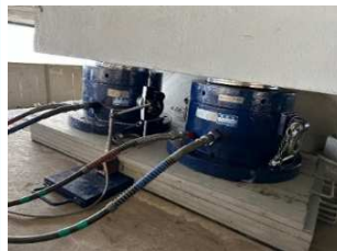
ジャッキ設置
