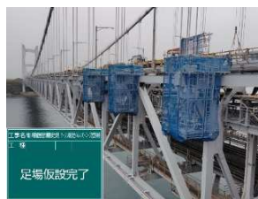
足場仮設完了
