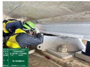
すべり板設置状況
