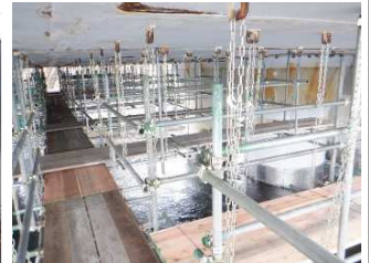
頂板裏面足場設置完了 (4P)
