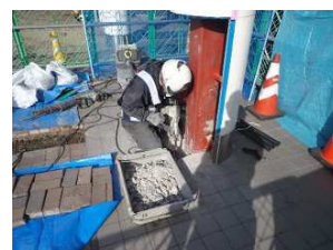
電線管理設作業
