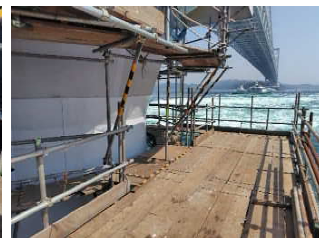
通路設置完了 (4P)
