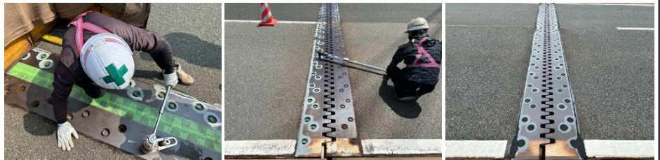
既設ボルト撤去
