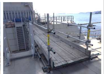
基部連絡通路設置完了 (4P)
