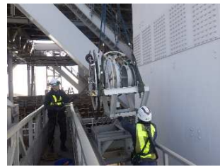
給電設備更新状況
