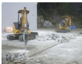
コンクリート 取壊状況
