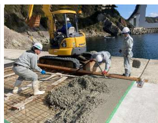
コンクリート 打設状況
