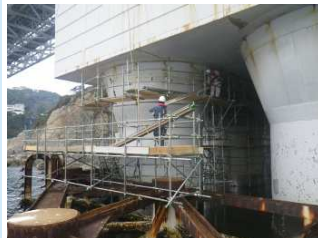
足場設置状況
