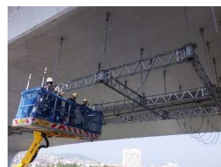
足場仮設状況
