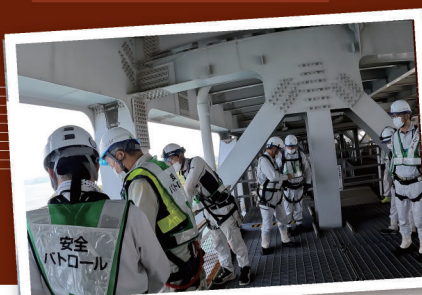
工事安全パトロール
